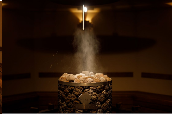
▲1時間に1度自動でサウナストーンに水分を落とす
